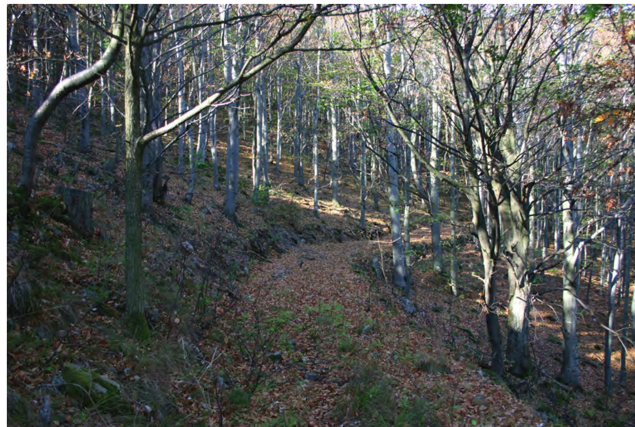
Vegyes szelvényben épített, árok nélküli, egy oldali keresztlejtésű erdészeti szállító-„barkácsoló” út; cserkelő ösvényből kialakítva az Őr-hegyen a Károlyi birtoklás idejéből
