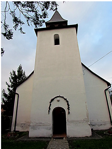
A füzéri református templom homlokzata
